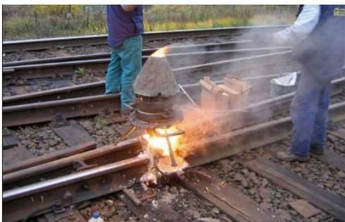
**FIGURA 4.** Reacción termita entre el aluminio y óxido de hierro<sup>3</sup>
